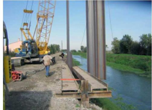
Afin de favoriser la mise en œuvre, les palplanches seront entreposées par tas pour permettre un accès rapide lors de l'élingage.
