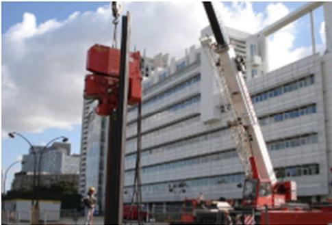
*Figure 27 Exemple de vibrofonçeur à fréquence standard. Source : [tecnoterra.ch](http://tecnoterra.ch)→*
