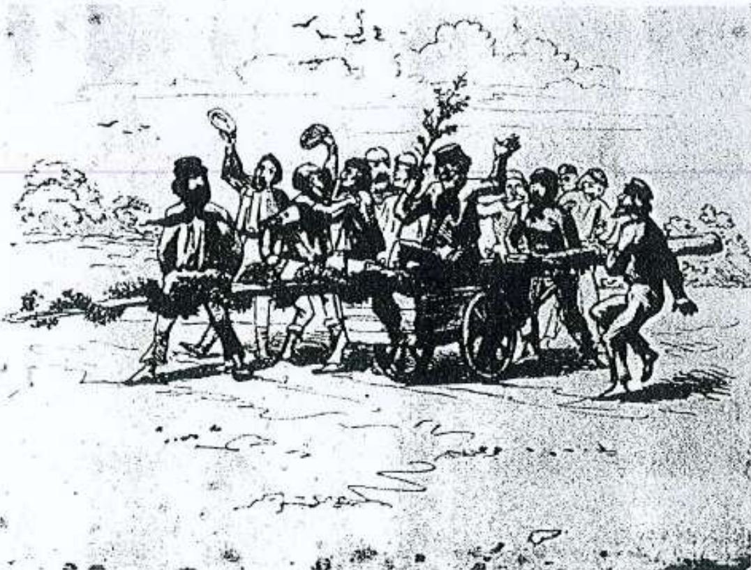
De eerste paal wordt versierd en wel naar de bouwput gebracht, voor de bouw van een huis in de P.C. Hoofstraat in Amsterdam (1872). The first pile is fully decorated taken to the building site, for the construction of a house in P.C. Hoofstraat in Amsterdam (1872).
