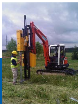
Mât monté sur bras de pelle
