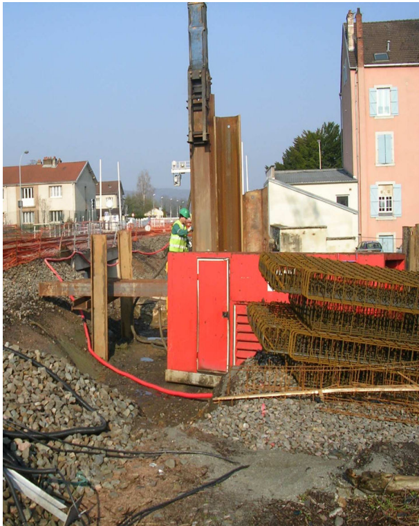
Figure 23 : Vesoul / Trépideur Menck120 à proximité de la voie
