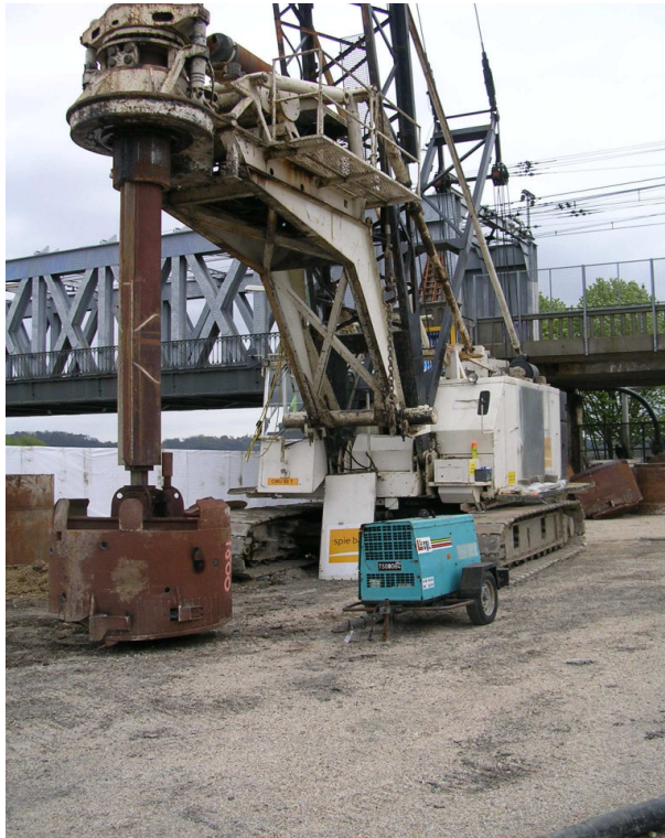
Figure 30 : Engin de forage (Becket)
