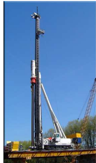
Figure 03 : Exemple d'opération de battage
