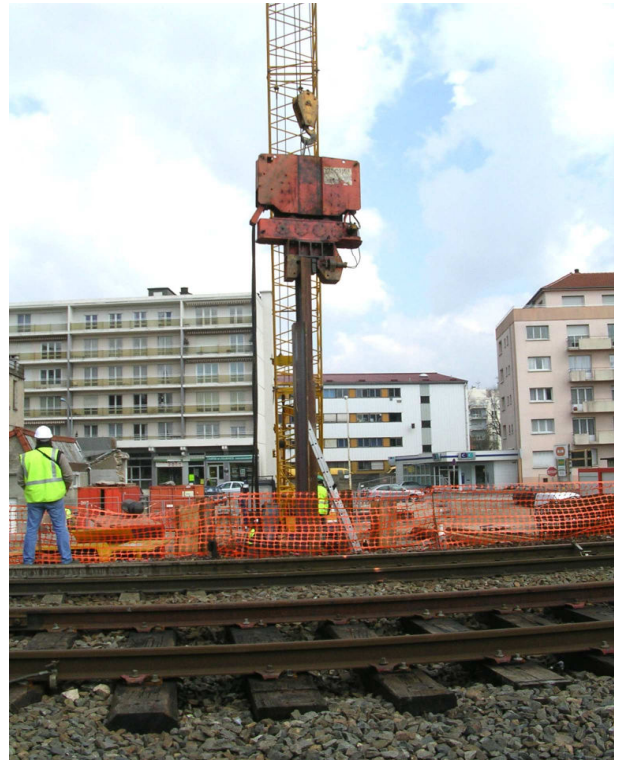
Figure 24 : Vesoul / Vibreur PTC20H et voies ferroviaires
