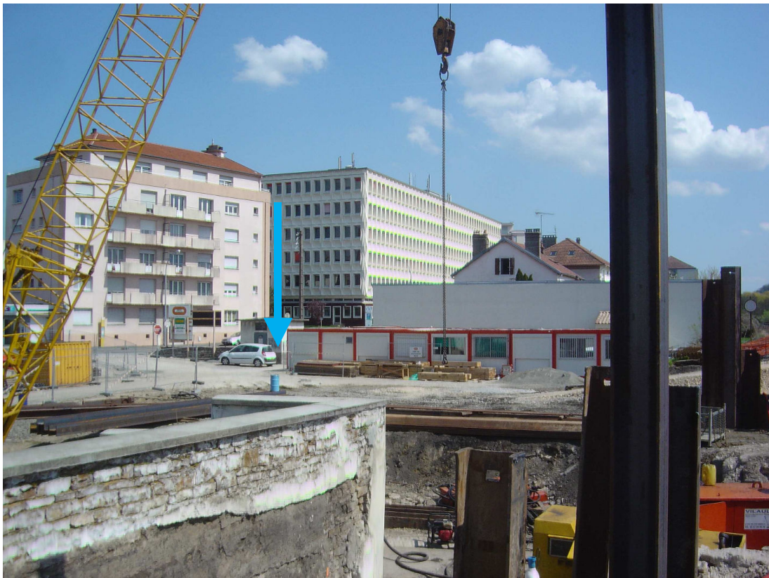
Figure 25 : vue d'ensemble du chantier
