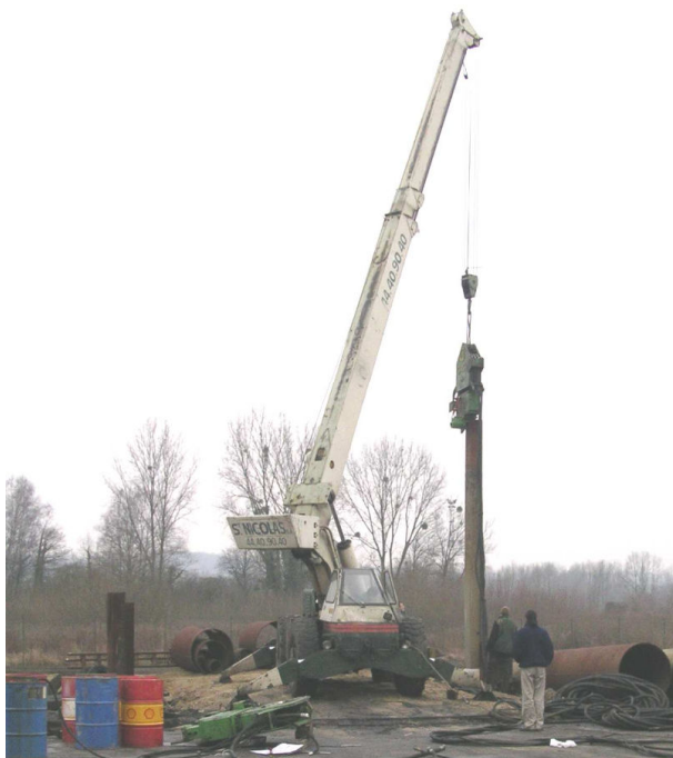
Figure 18 : Verberri / Vibrofonçeur ICE216
