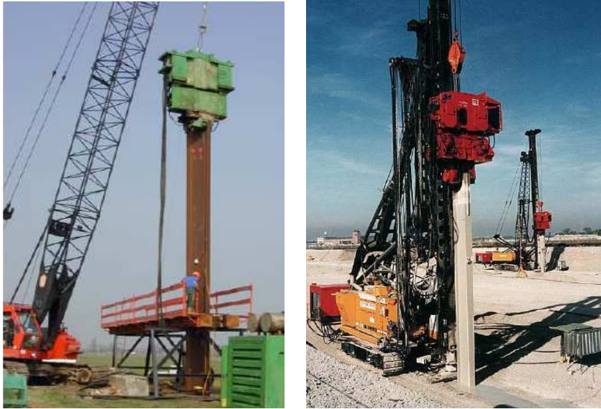
Figure 01 : Exemples d'opérations de vibrofonçage
