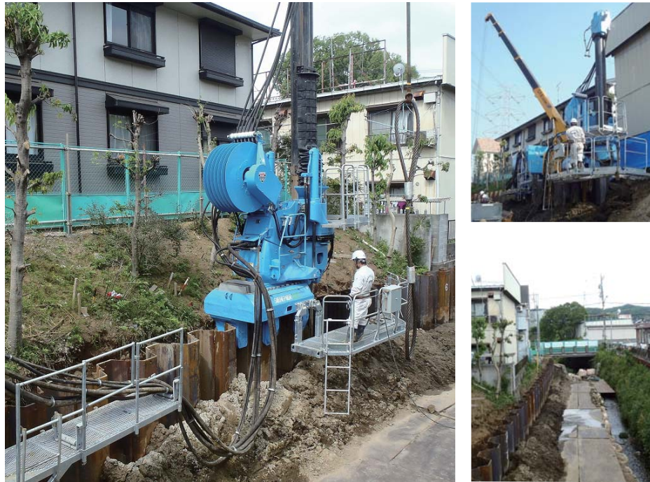
Projet : Travaux de construction de la canalisation publique, réseau d'égouts pluvial de la ville de Machida Lieu : Ville de Machida, Tokyo Période : Mai 2013 Vérineur : F201 Type de palplanche : Palplanche en U SP VL Longueur de fiche : 8,5 m
