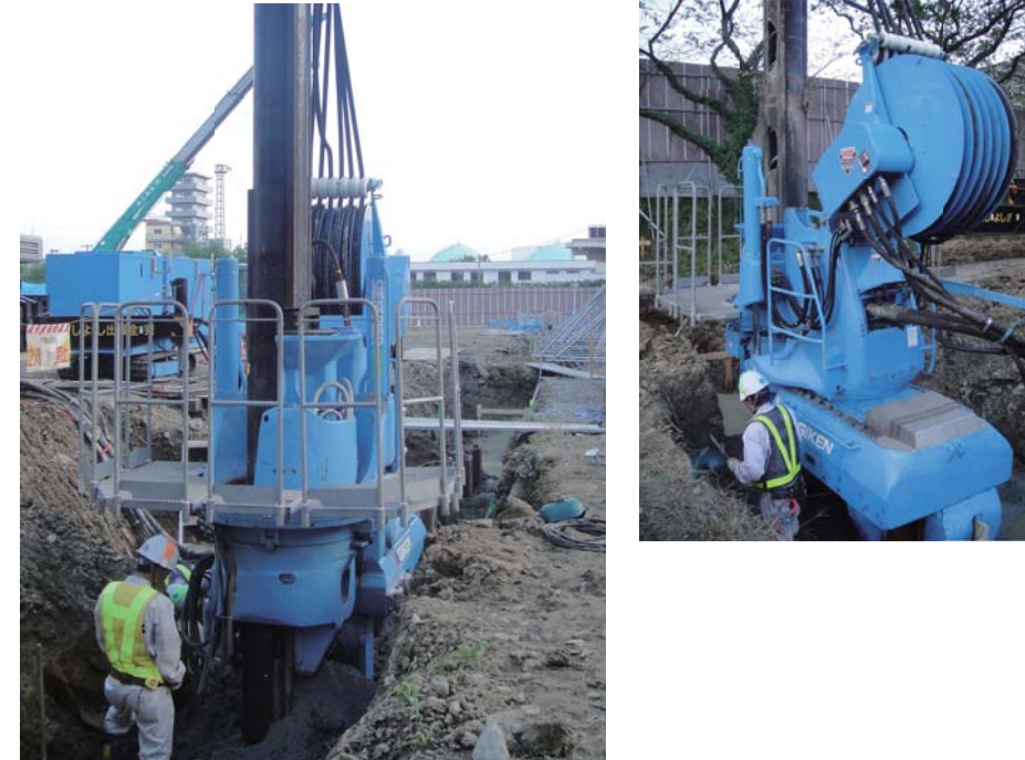
Projet : Démolition de l'édifice préfectoral de la santé publique et de l'environnement de Miyagi. Deuxième phase Emplacement : Ville de Sendai, Miyagi Période : Octobre 2013 à Novembre 2013 Vérineur : F201 Type de palplanche : J Pocket Pile JFESP-4WS, Palplanche en U SP II w Longueur de fiche : 4,0 à 7,5 m
