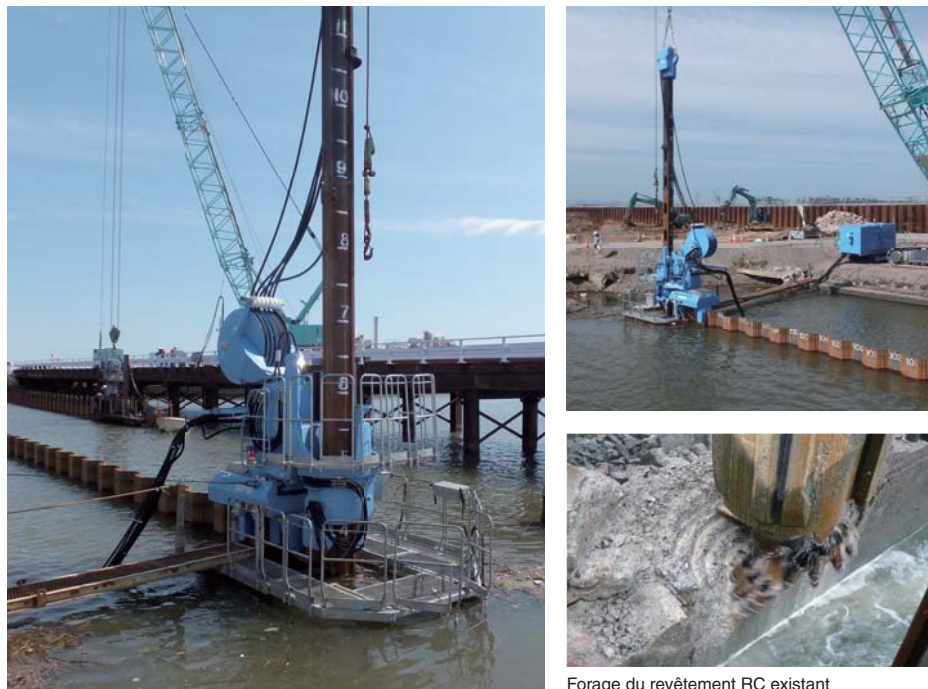
Projet : Travaux de restauration de digue Section 4, rivière de Natori Emplacement : Ville de Natori, Miyagi Période : Septembre 2013 à Octobre 2013 Vérineur : F201 Type de palplanche : Palplanche en U SP IIIw et SP IVw Longueur de fiche : 7,5 à 16,5 m
