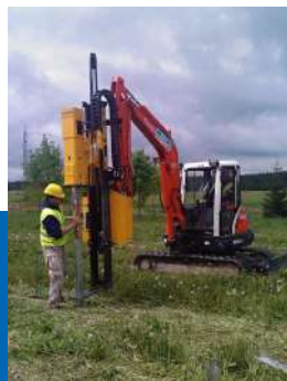
Mât monté sur bras de pelle
